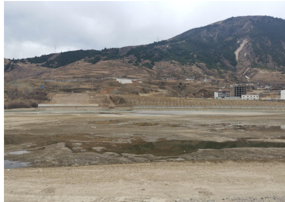
项目鲜水河右岸堤防段
