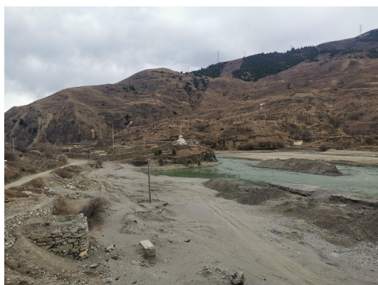
项目鲜水河疏浚段
