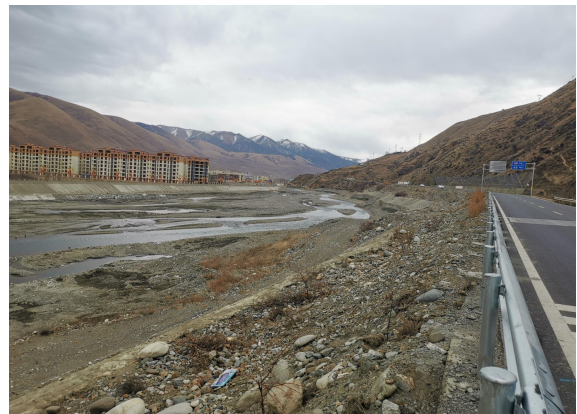
项目柳日河堤防工程段
