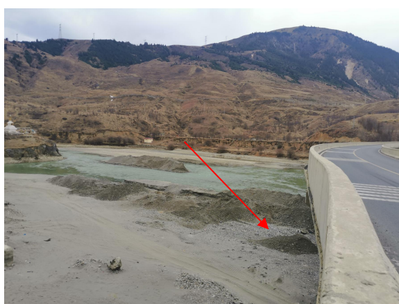
项目鲜水河左岸堤防起点
