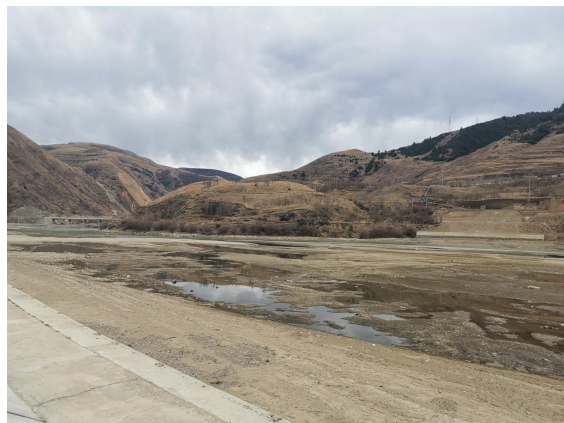
项目鲜水河右岸堤防段
