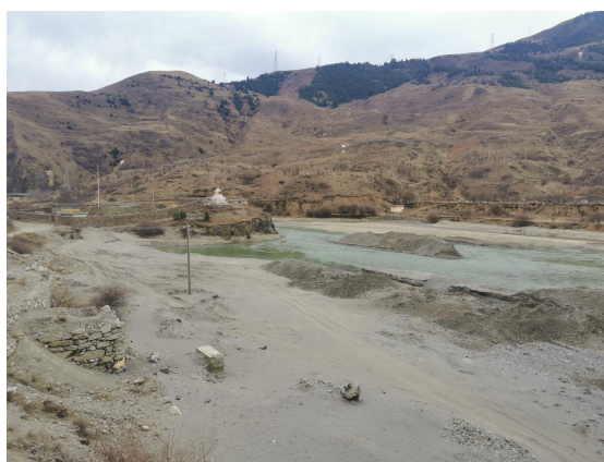
项目鲜水河左岸堤防段
