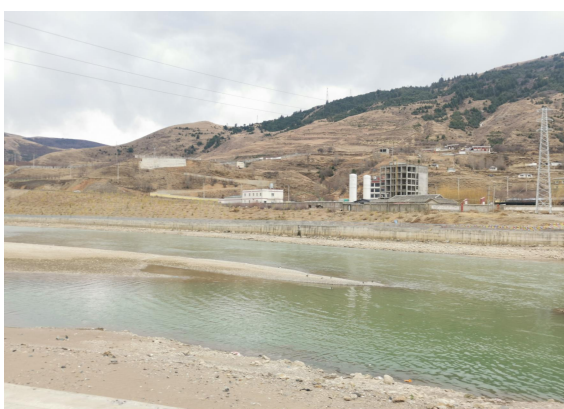
项目鲜水河右岸堤防加高段
