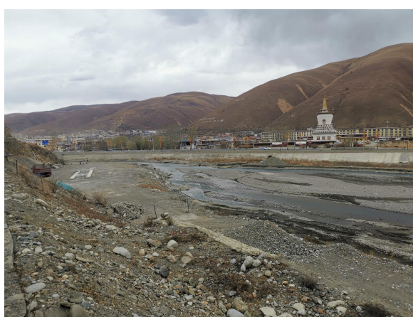
项目柳日河堤防工程段
