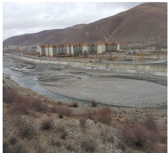
项目柳日河堤防工程段
