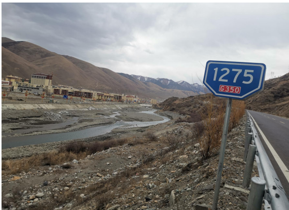
项目柳日河堤防工程段
