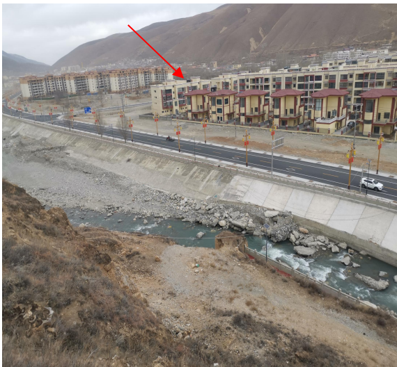
项目柳日河段堤防起点及居民小区
