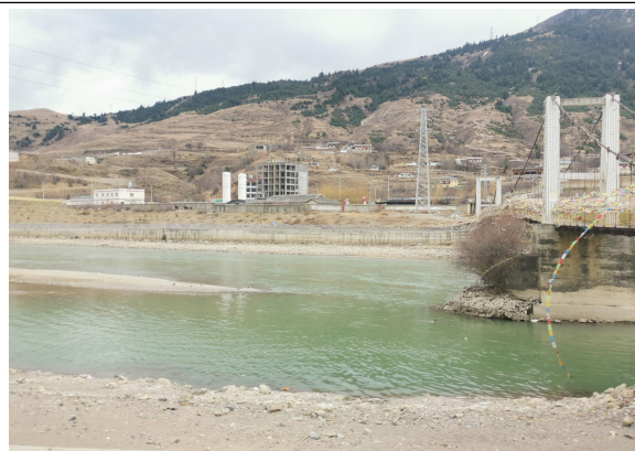
项目鲜水河右岸堤防加高段
