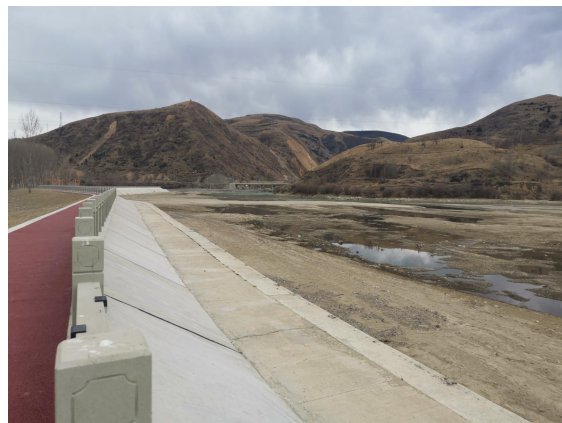
项目鲜水河右岸堤防段
