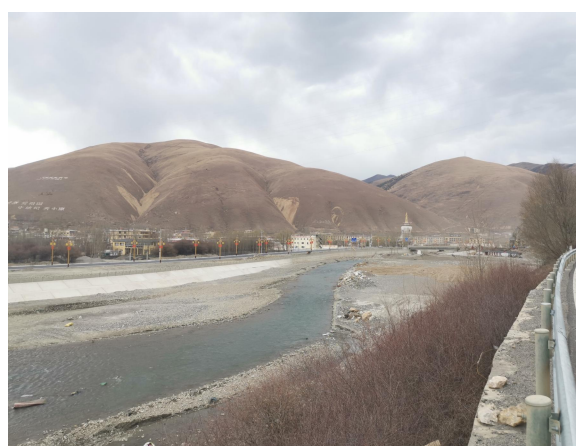
项目柳日河堤防工程段
