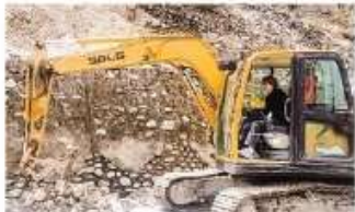
刘金梦正在施工现场忙碌。
