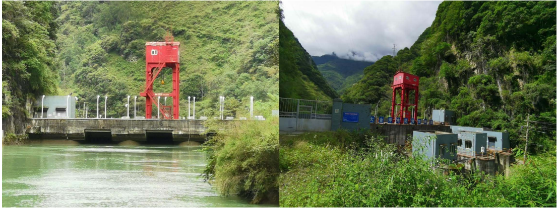
厂址下游 -大金坪电站湾坝河取水枢纽库区及坝址现状
