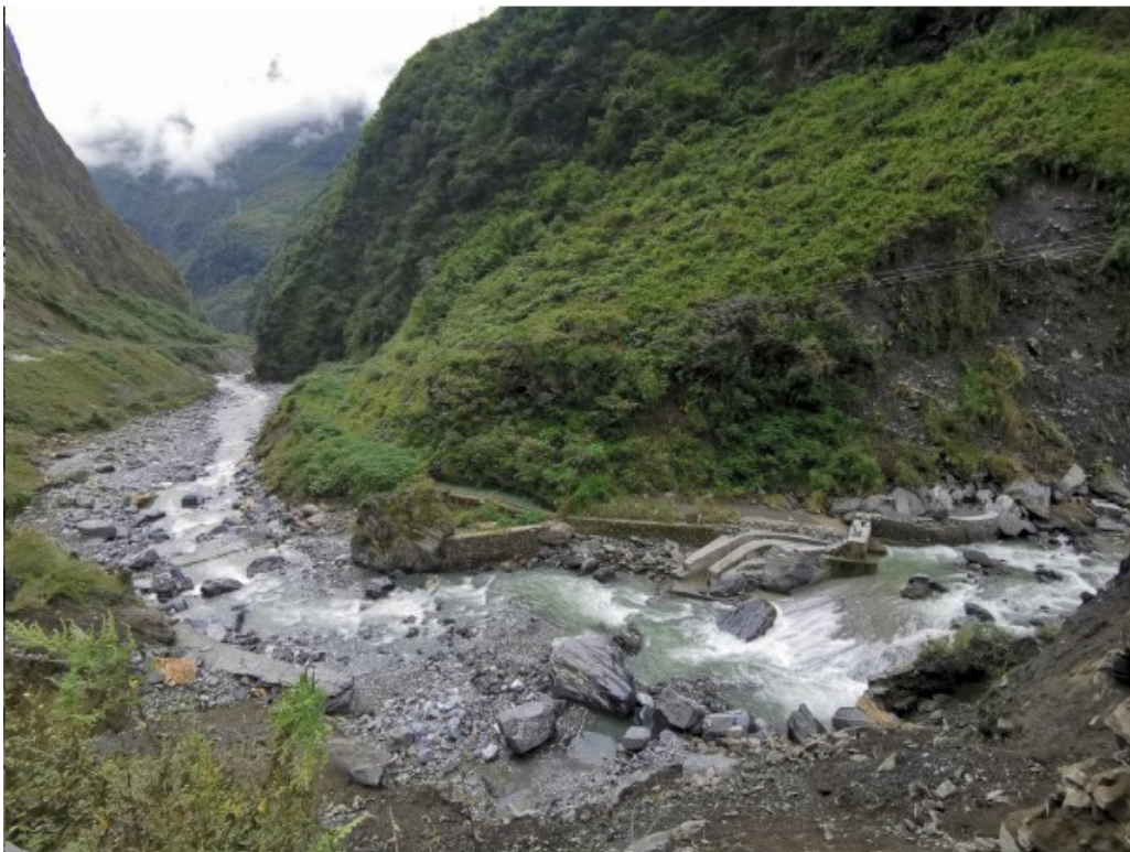
湾坝河取水枢纽
