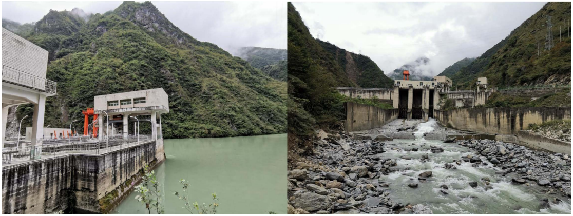
湾坝河取水口上游-湾二（玉龙）电站库区及坝址现状
