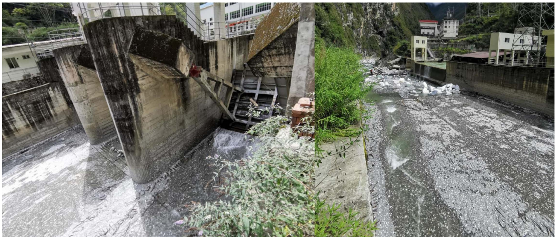
厂址下游-湾一电站取水枢纽现状
