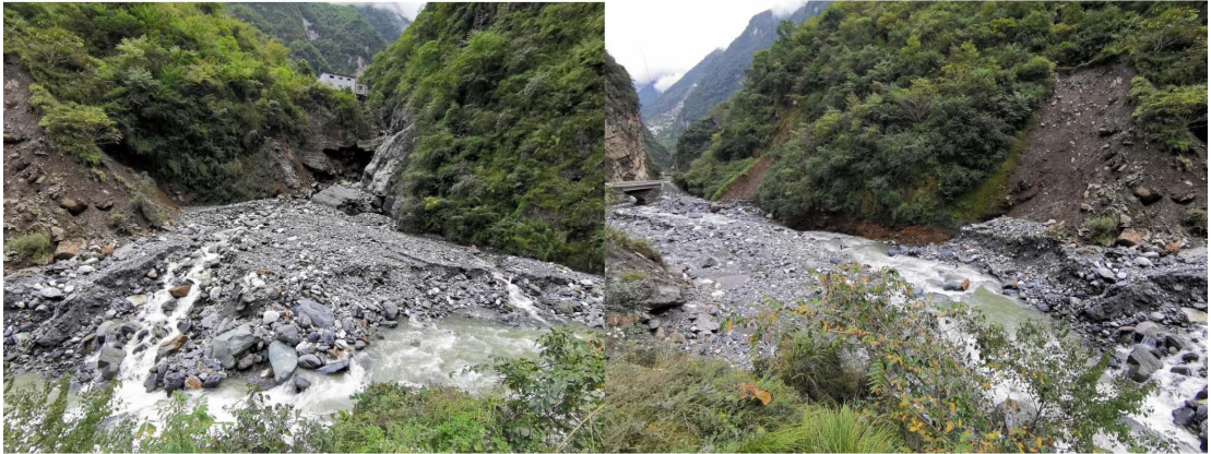
图 4-3 岩棚子沟汇入口下游河段
