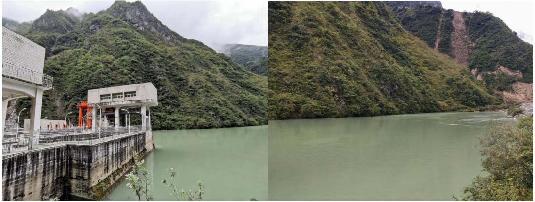
湾二（玉龙）电站库区
