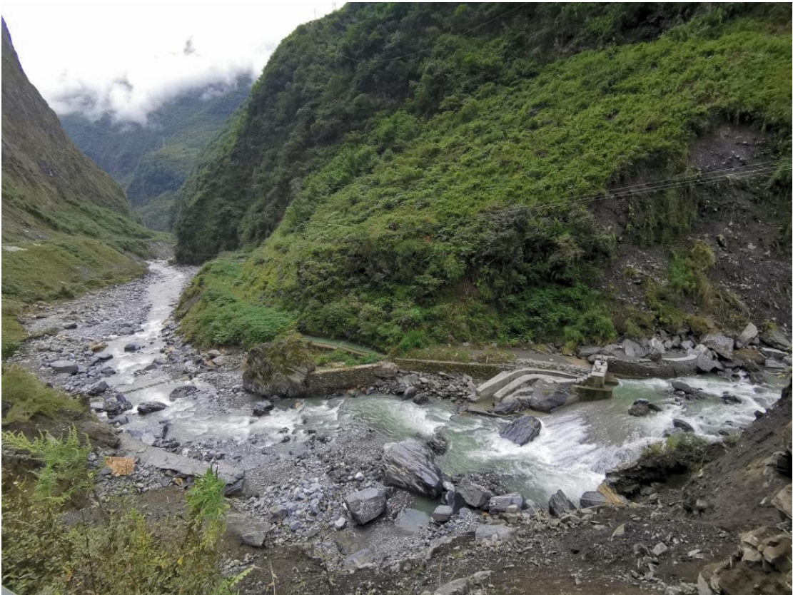
图 4-2 湾坝河取水枢纽下游河段
