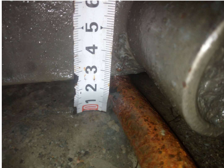
阮家沟闸门抬升高度
