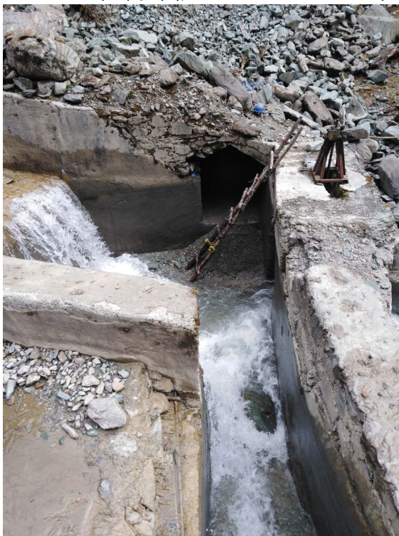
阮家沟取水枢纽
