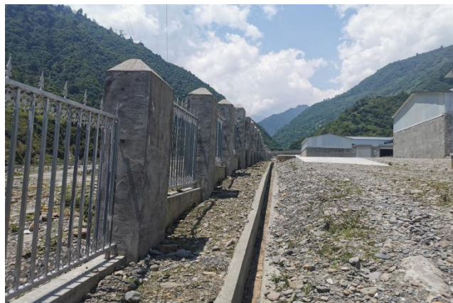
厂区边侧排水沟
