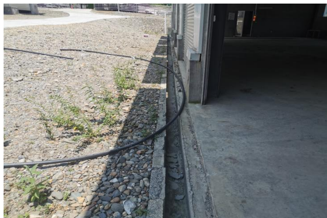
库房前排水沟
