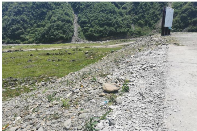
填方边坡现状
