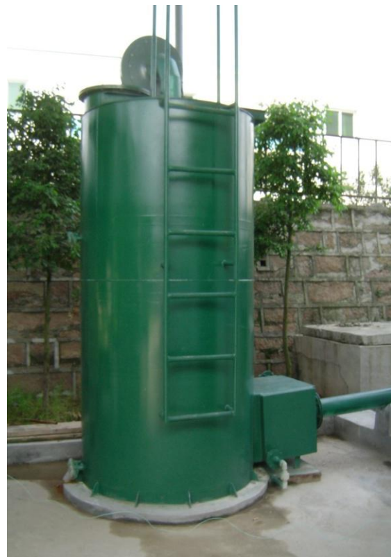
图 2.6-7 脱臭塔照片
