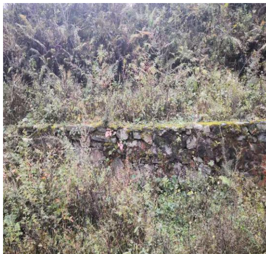
渣场挡墙及植被恢复
