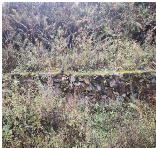
渣场挡墙及植被恢复
