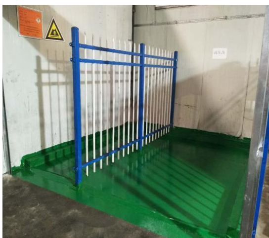
地面防渗+围堰（工程样图）
