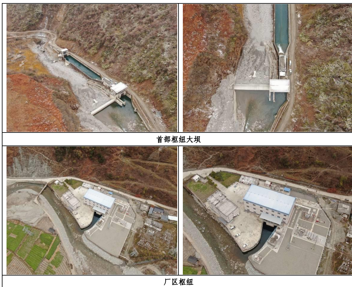
图1-2 主体工程现状
