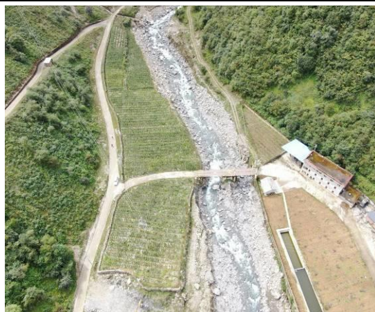
2#临时弃渣场复耕
