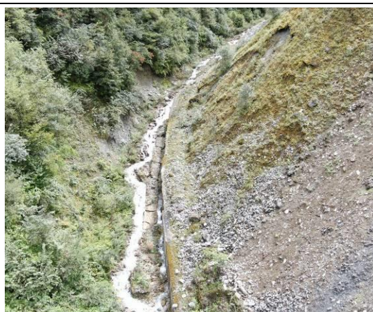
4#弃渣场挡渣墙
