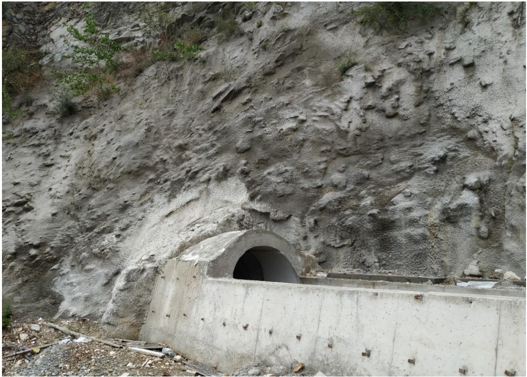
左干渠隧道出口护坡
