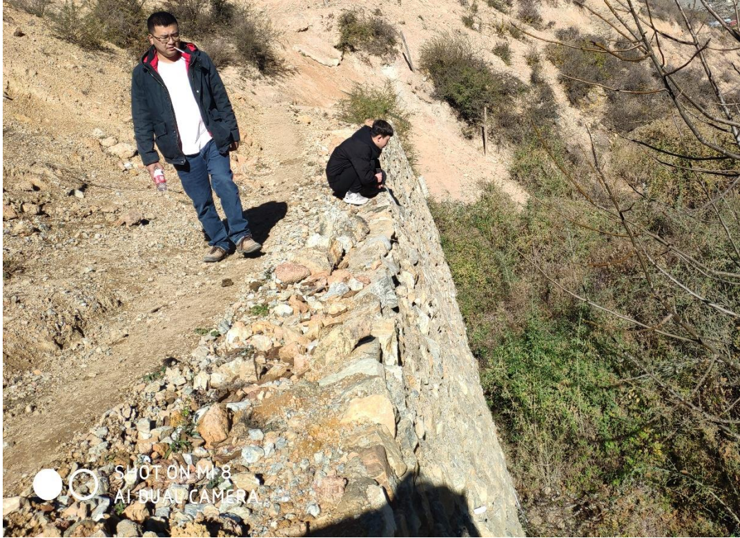
3#弃渣场挡墙测量
