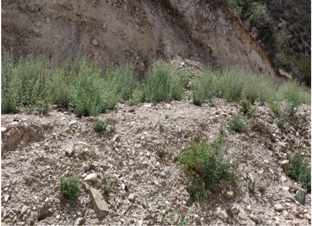
左干渠渠顶绿化
