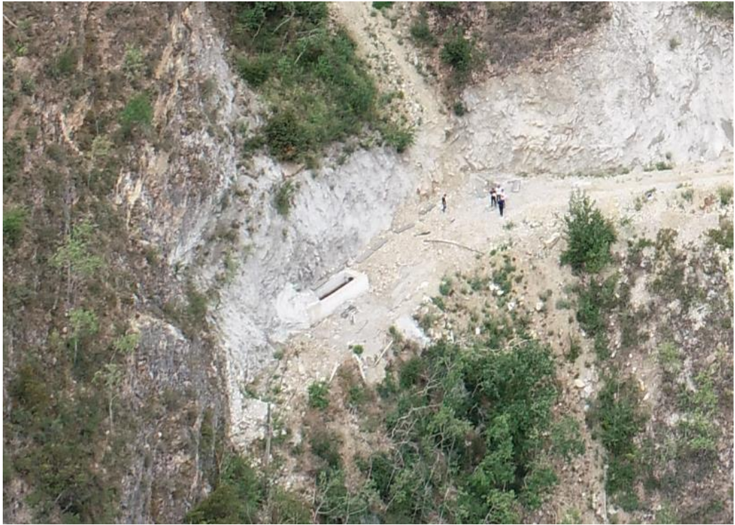
左干渠隧道出口
