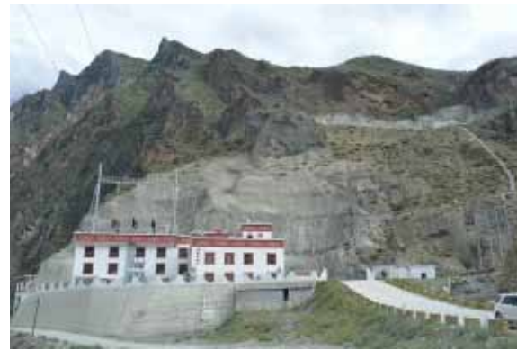
开关站喷混凝土护坡
