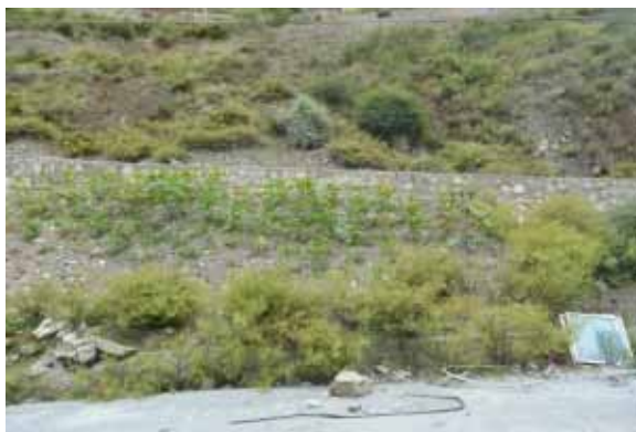
施工道路边坡种植菴麻绿化
