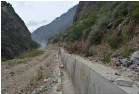
施工道路两侧排水设施
