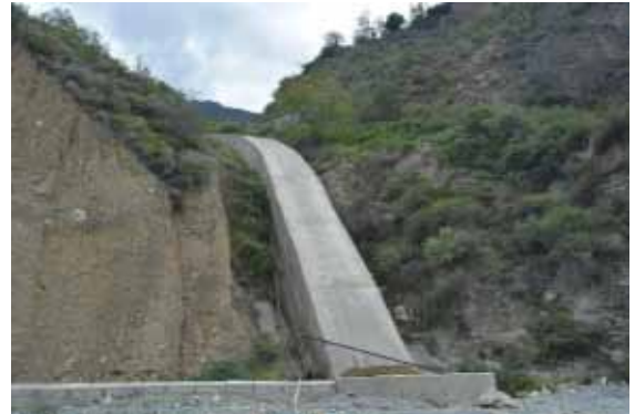
2#渣场后方汇水管涵
