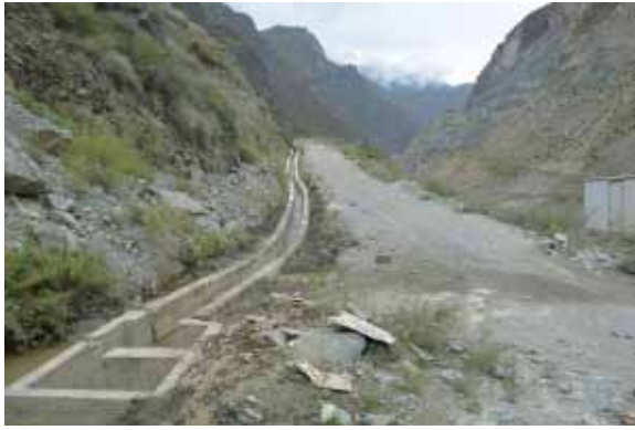
施工道路两侧排水设施
