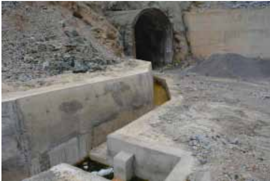
施工支洞排水设施
