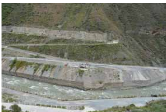
施工道路平整
