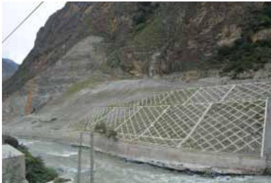
1#渣场框格梁护坡
