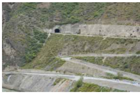
施工道路绿化
