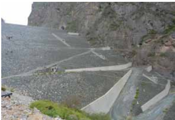
上坝公路两侧挡防
