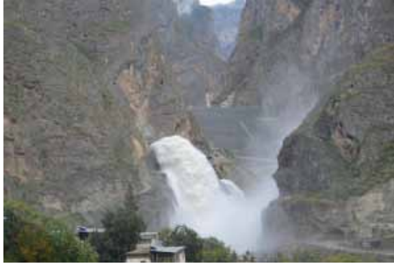
电站坝址航拍全貌
