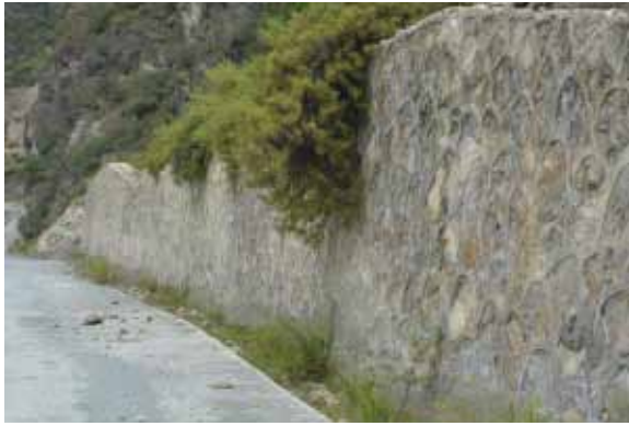
施工道路侧浆砌石挡墙
