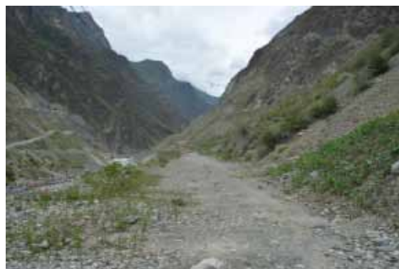
施工道路两侧撒播格桑花
