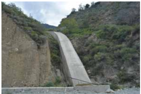
2#渣场后方汇水管涵
