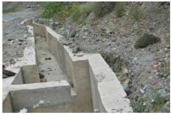
施工道路两侧排水设施
