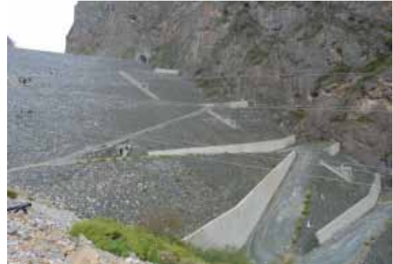
上坝公路两侧挡防
