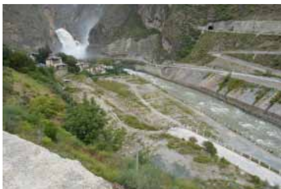
施工营地覆土绿化
