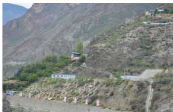
道路边坡框格梁护坡及绿化
