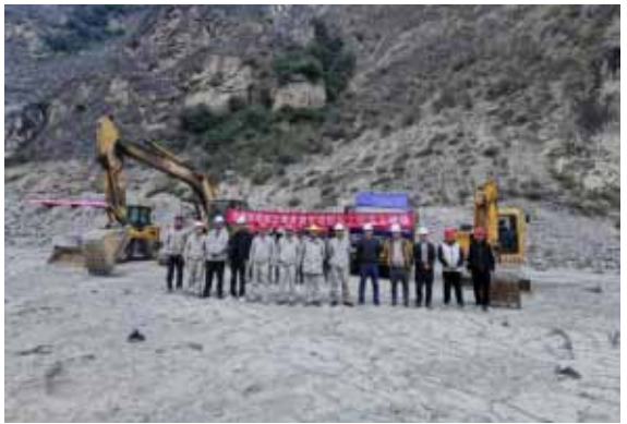
土地复垦单位进场
