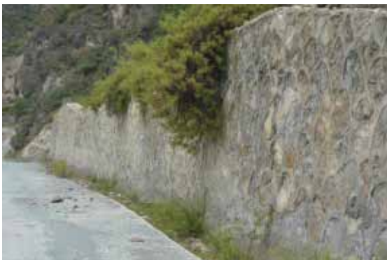
施工道路侧浆砌石挡墙
