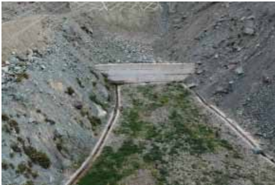
2#渣场周边排水
