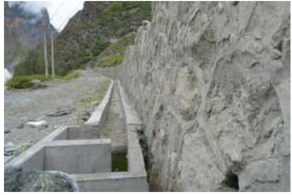
施工道路两侧排水设施
