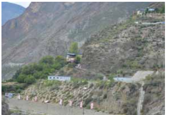
道路边坡框格梁护坡及绿化
