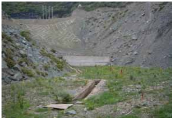
2#渣场坡脚挡墙
