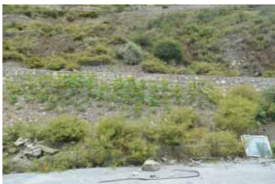
施工道路边坡种植蓖麻绿化
