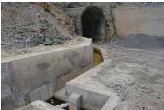
施工支洞排水设施
