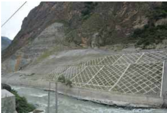
1#渣场框格梁护坡
