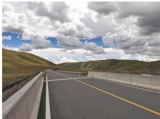
桥梁混凝土防撞护栏
