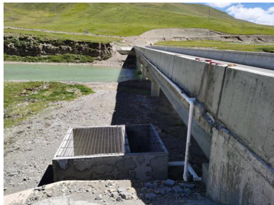
雅砻江大桥 桥面径流收集系统
