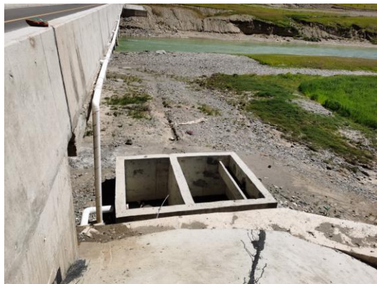
雅砻江大桥 桥面径流收集系统
