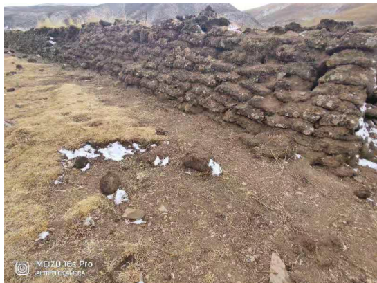
永久占地区草皮剥离暂存
