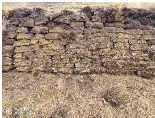
永久占地区草皮剥离暂存
