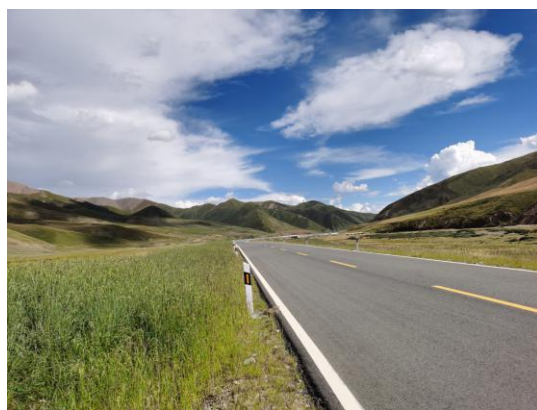
路堤边坡 绿化
