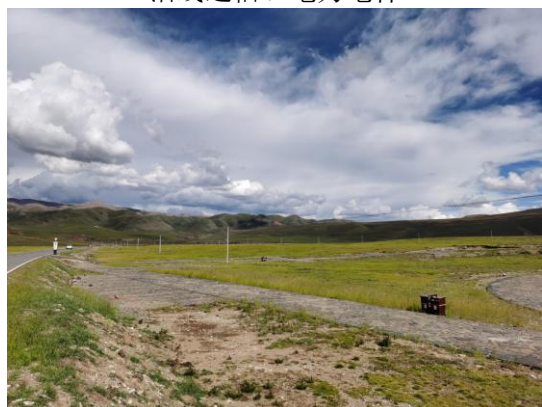
石经城支线沿线通信、电力电杆
