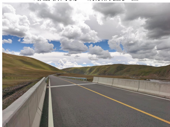
桥梁混凝土防撞护栏
