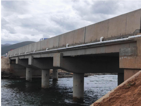
那让中桥 桥面径流收集管
