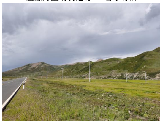
沿线通信、电力电杆
