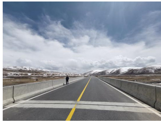
桥梁混凝土防撞护栏
