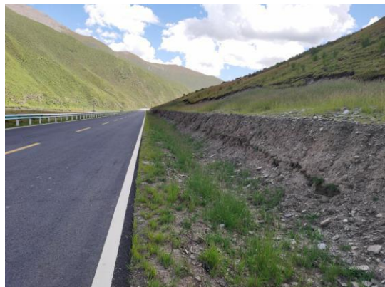
饮用水源保护区路段 土质排水沟
