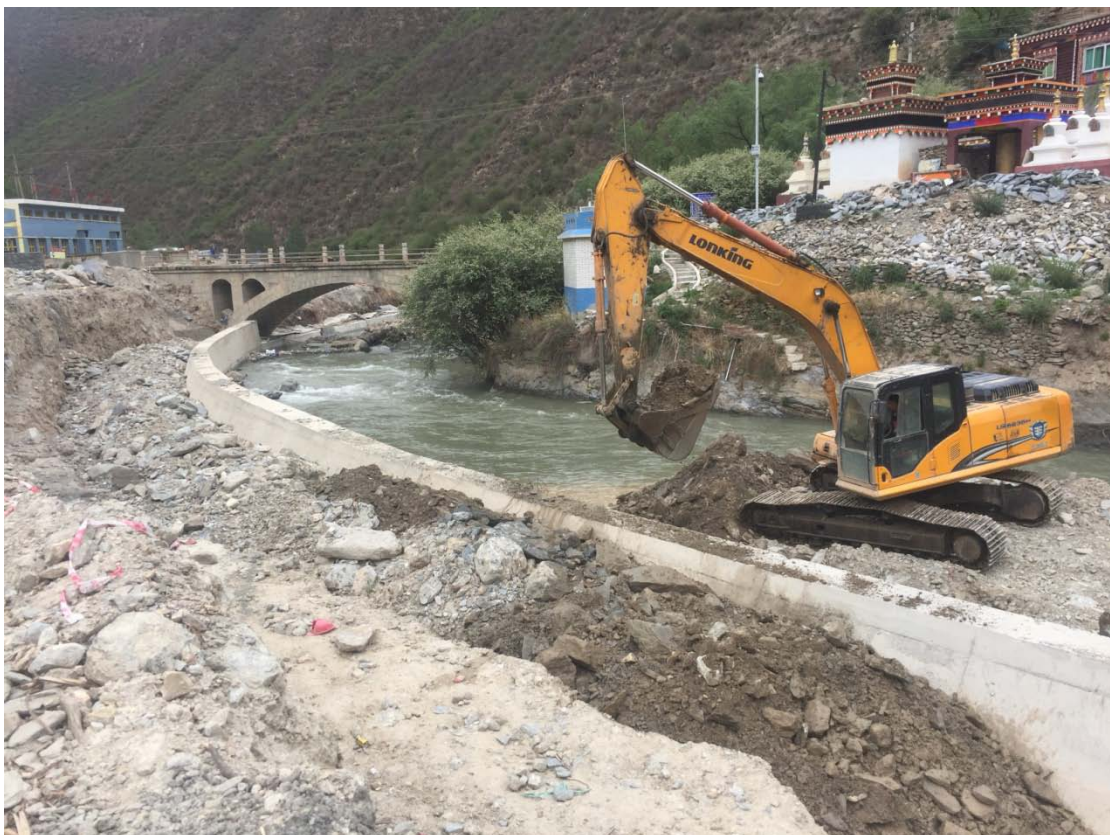
施工现场照片（四）
