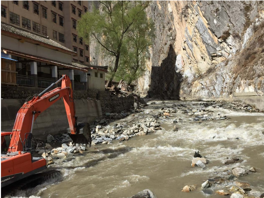
施工现场照片（三）
