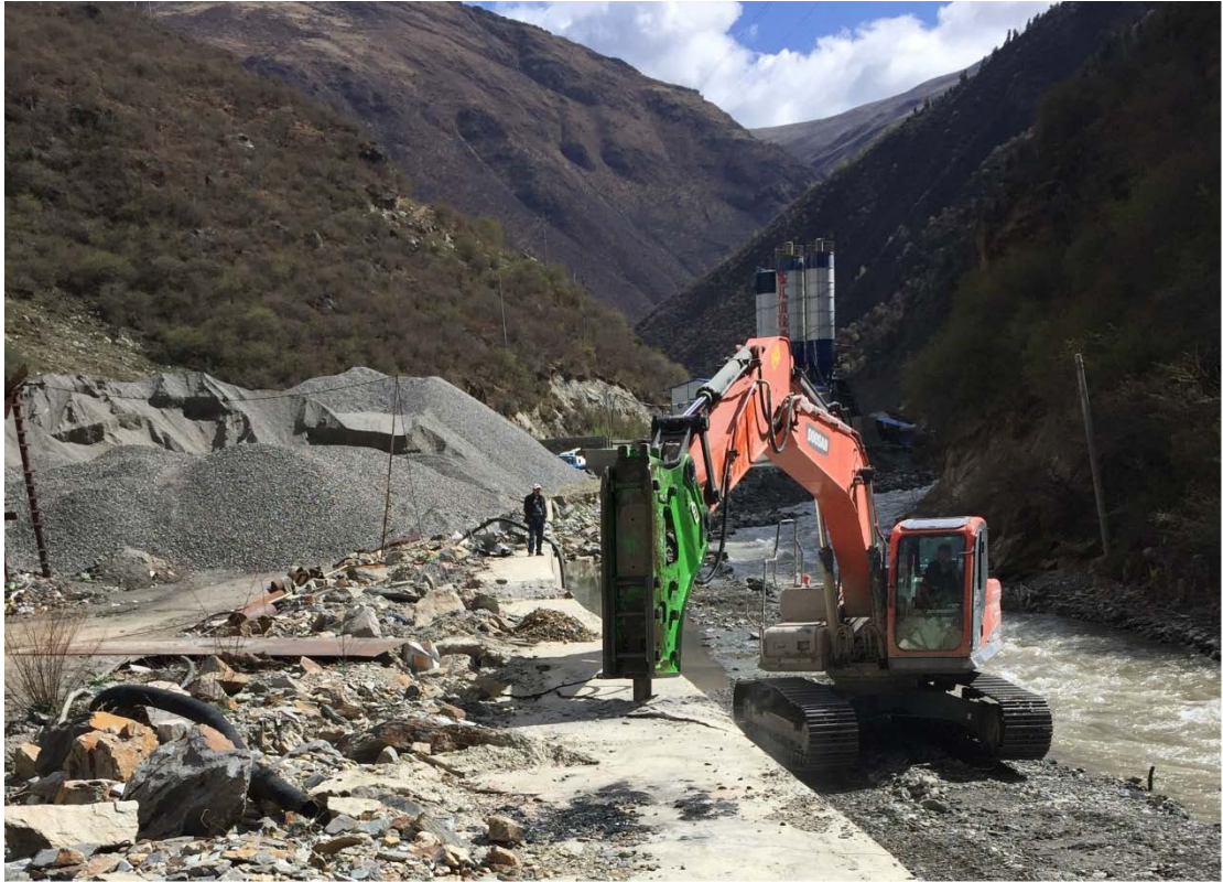
施工现场照片（一）
