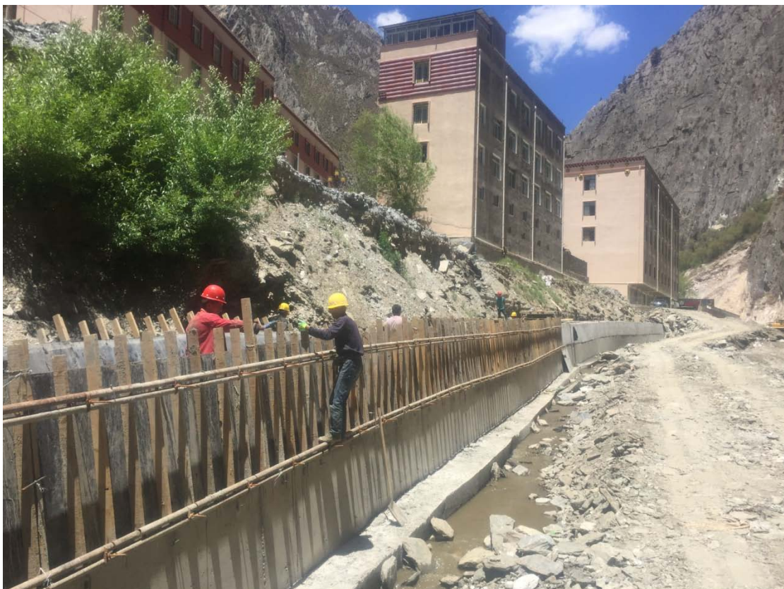
施工现场照片（二）
