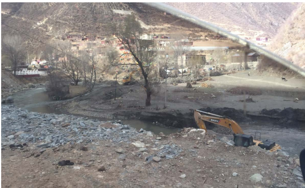
施工现场照片（二）
