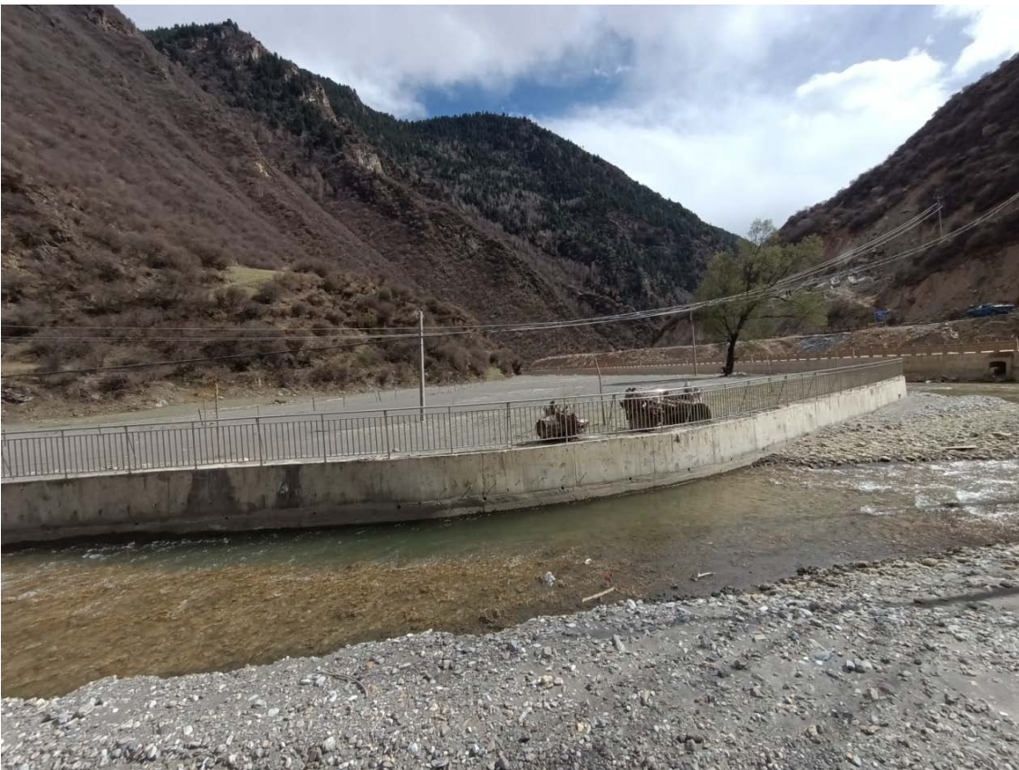
施工现场照片（四）
