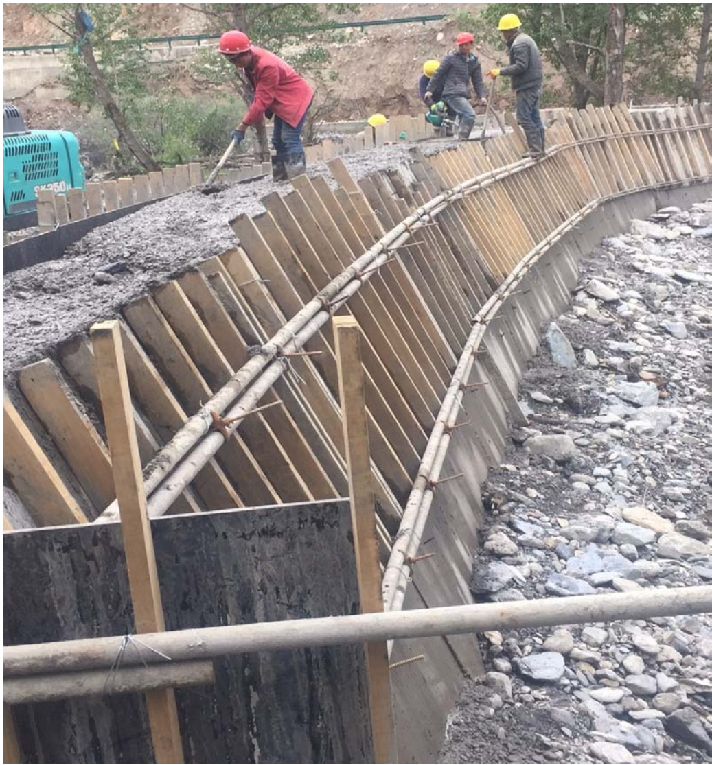
施工现场照片（一）
