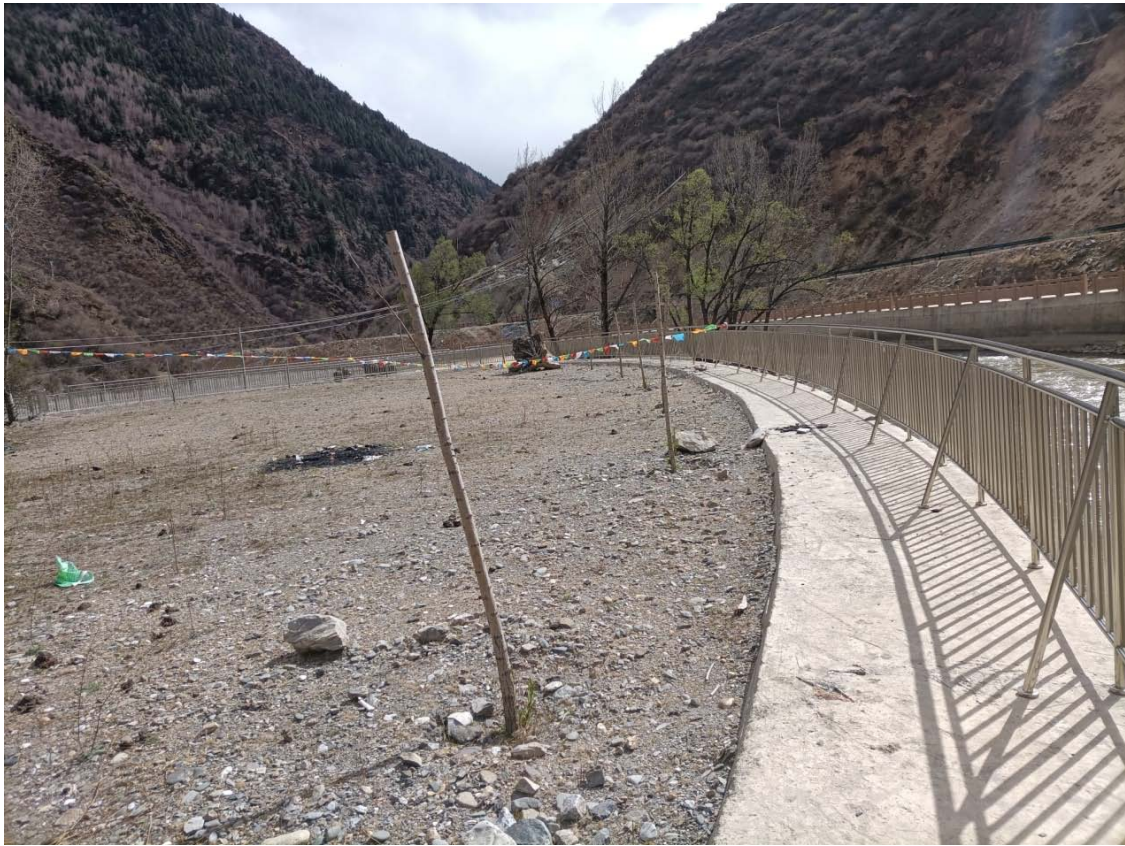
施工现场照片（三）
