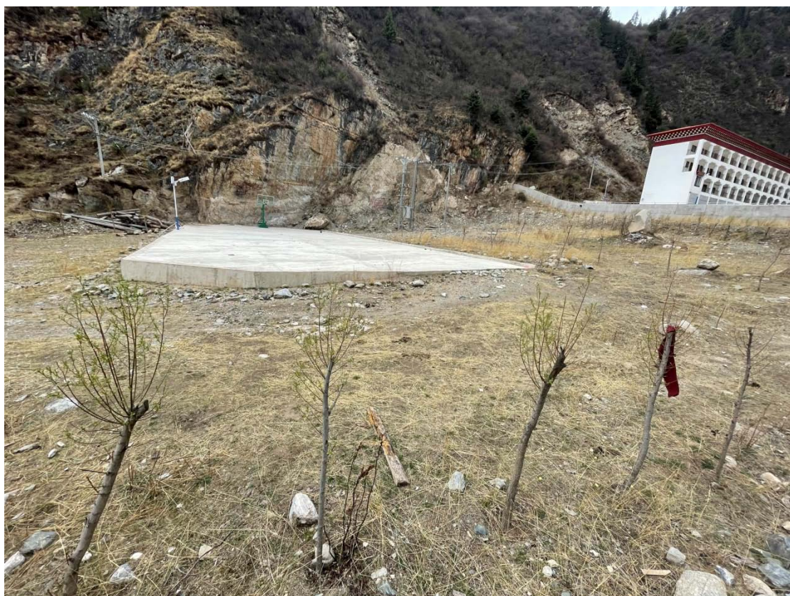
临时堆放场现状
