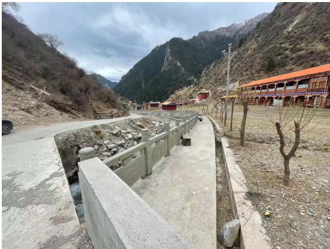
堤防工程区现状
