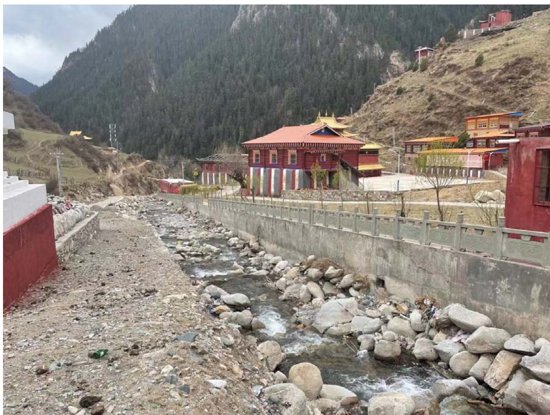
堤防工程区现状
