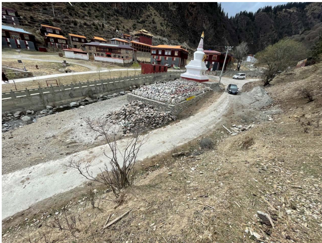
施工生产生活区现状
