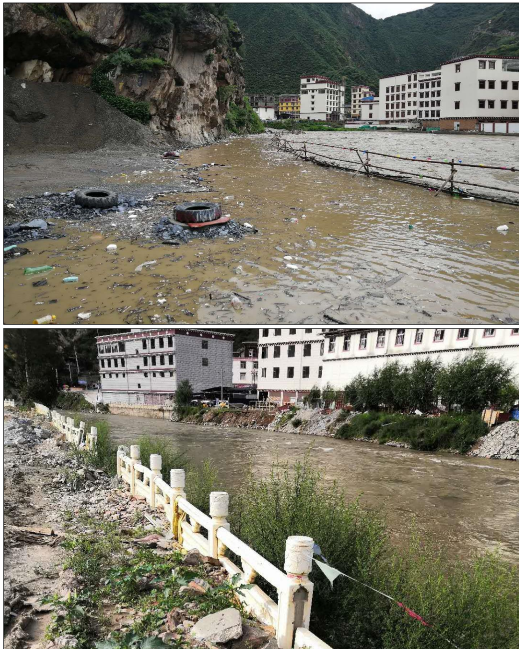
图2-2 工程区现状照片
