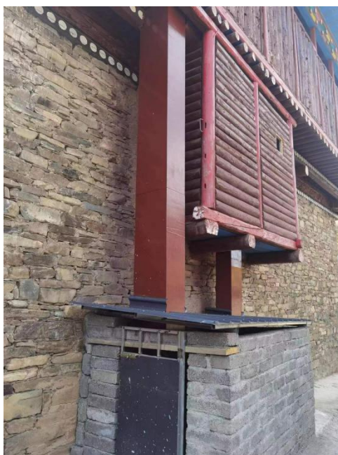
图 7-4 旱改卫厕所构造示意图
