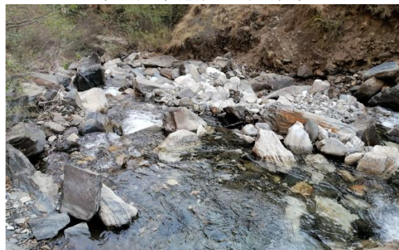
项目2#取水枢纽石头沟支沟现状
