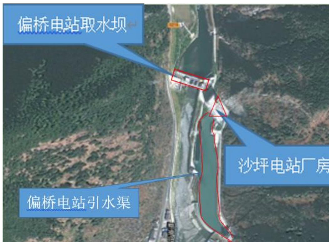
偏桥电站坝址处现状
