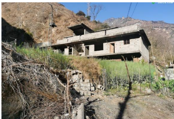
电站厂区现状
