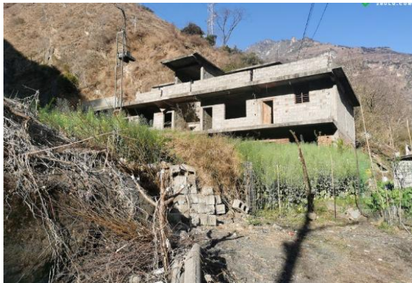
电站厂区现状
