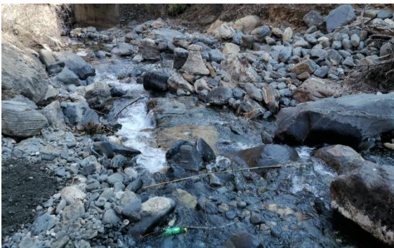
石头沟主沟坝址处现状
