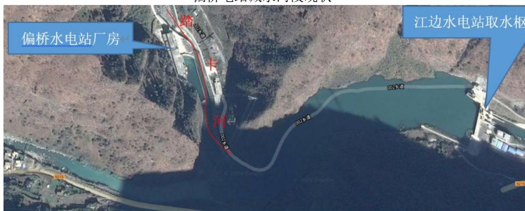
偏桥电站厂房河段现状
