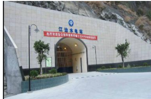
江边电站厂房处现状
