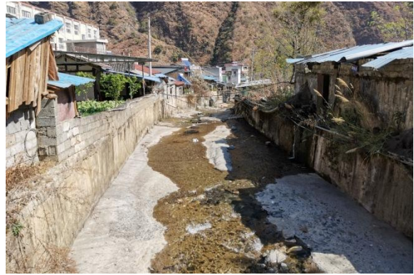
拟建尾水渠处河道现状
