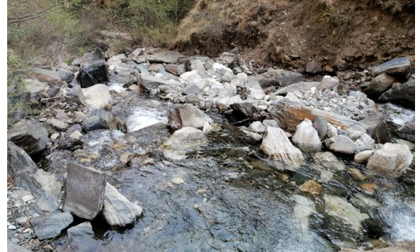
项目2#取水枢纽石头沟支沟现状
