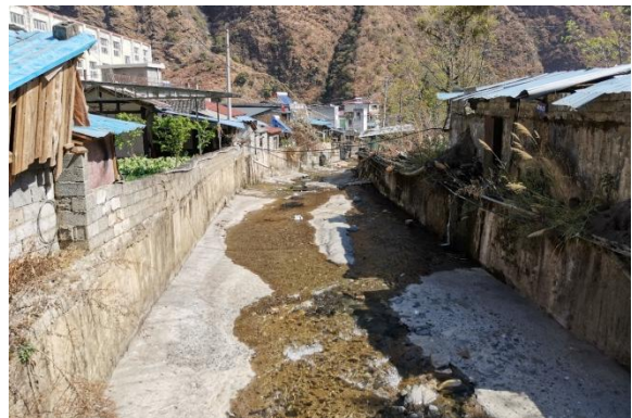
拟建尾水渠处河道现状
